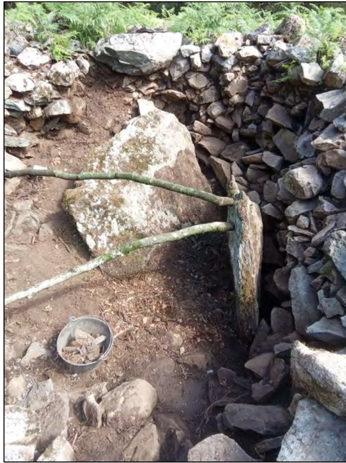
Figura 11. Desplazamiento de la losa lateral a
