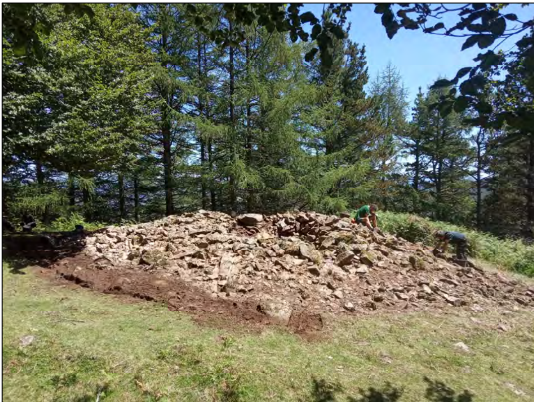
Figura 5. Trabajos de limpieza.
