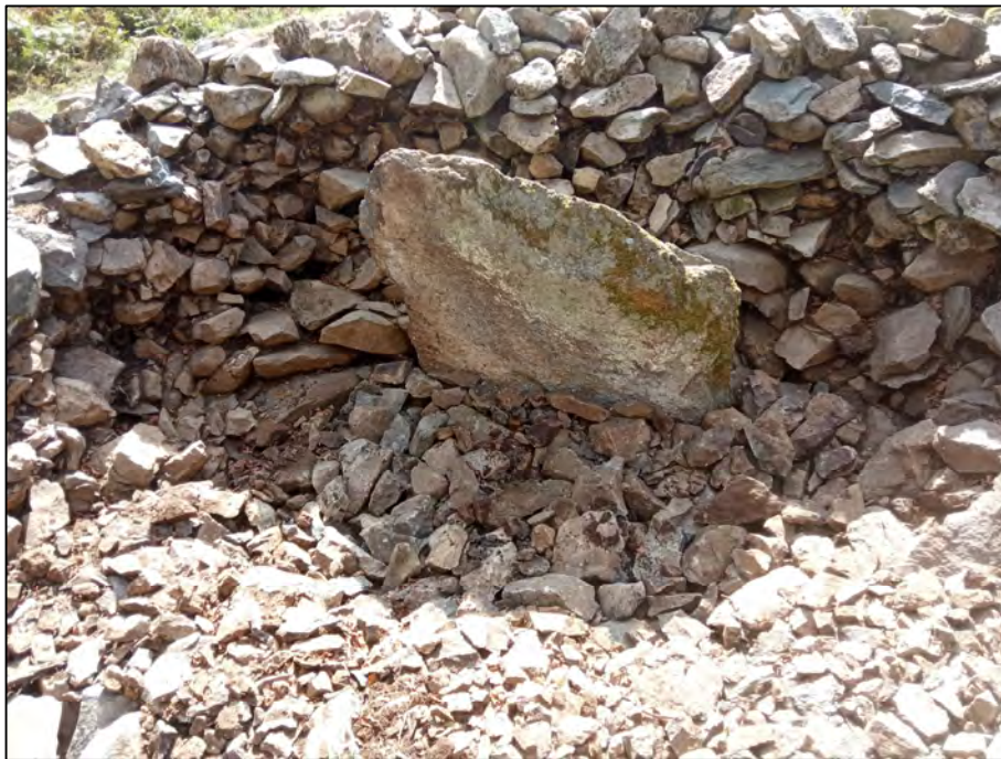
Figura 12. Relleno del área de la cámara
